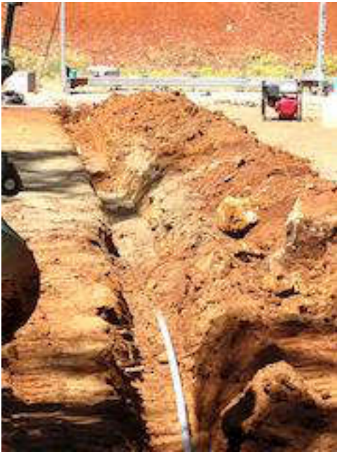
3. Vue générale des travaux
