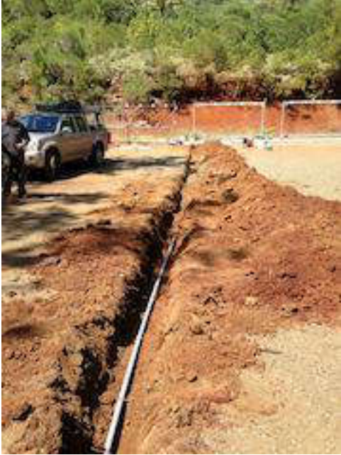
1. Pose du câble
