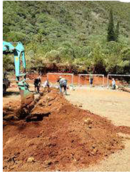
6. travaux de remblaiement en bonne voie
